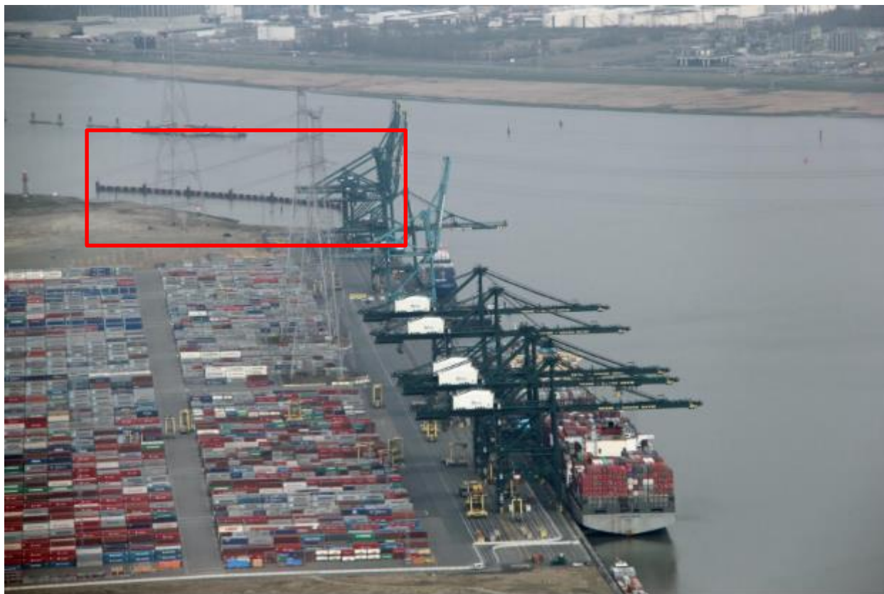
Figuur 8-29: Foto van de ingang van het Deurganckdok met aanduiding van de Current Deflecting Wall.
