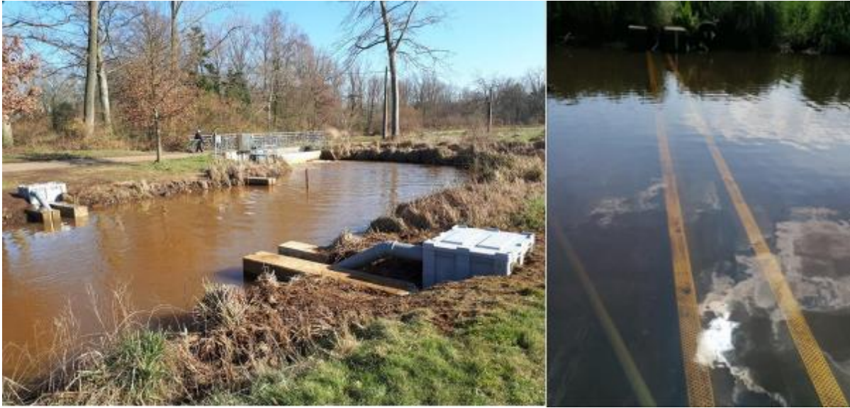
Figuur 8-55: Krabbensleuf te Grobbendonk in werking, de krabbensleuf bevindt zich volledig onder water.
